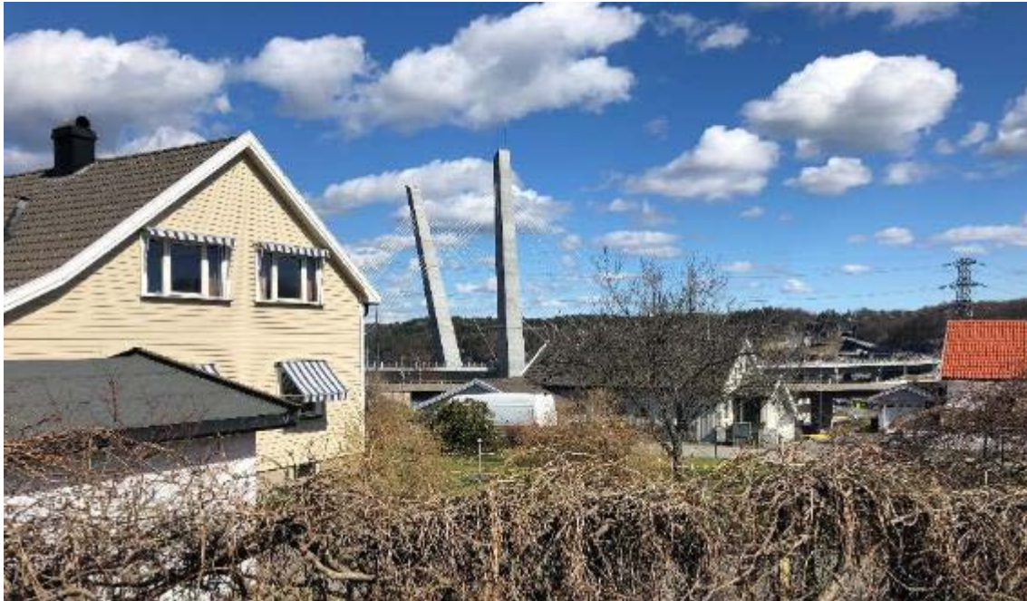
Figur 7-16: Bebyggelsen ved den åpne byggegropa ved Granveien er allerede i dag preget av naboskapet til det nye vegsystemet ved Farriseidet.
