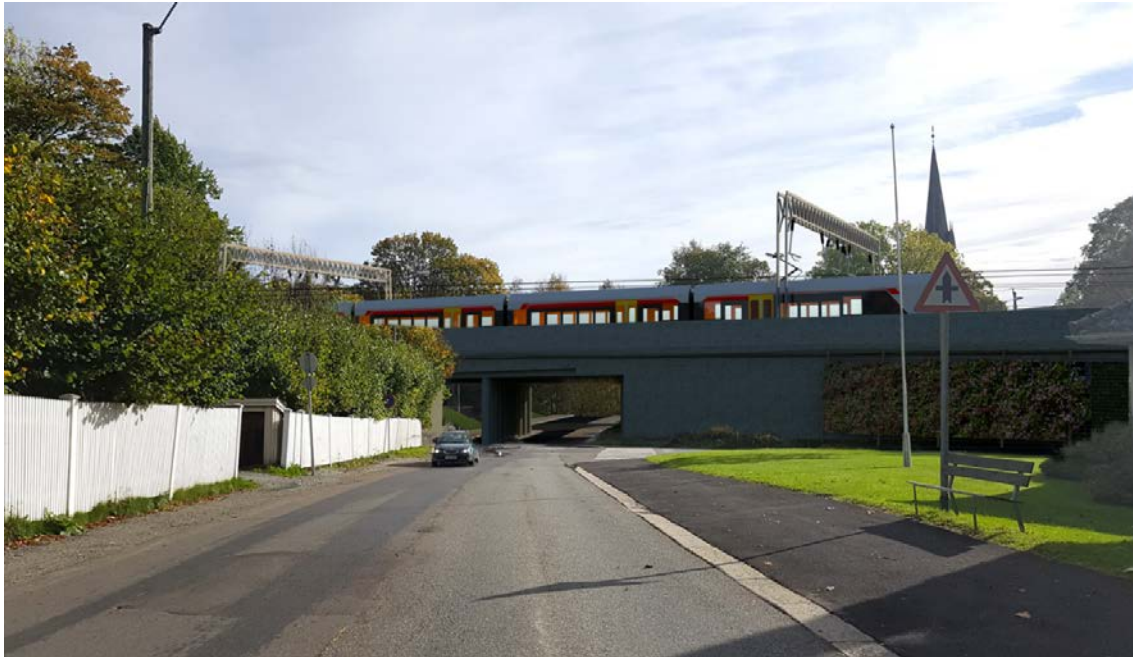
Figur 5-45: Hevede spor og ny Sandefjord stasjon skaper en viss barriereeffekt sett fra boligområdene nord for stasjonen. Fotomontasje sett fra Dølebakken basert på foreløpig tiltak.
