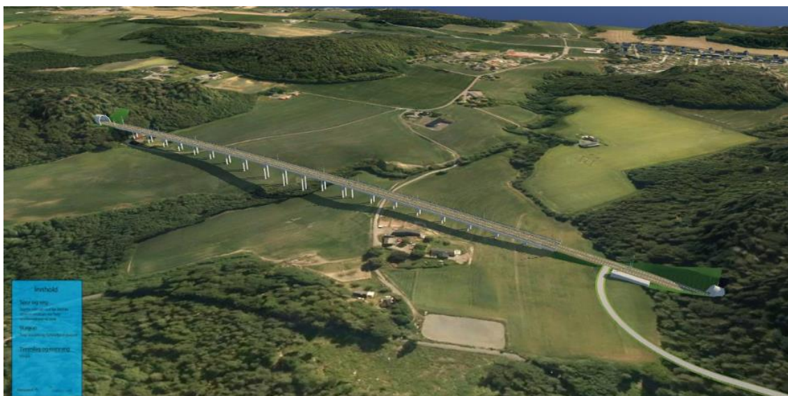
Figur 5-13: Kryssing av dalgangen ved Unneberg i Torp vest-korridoren. Retning Sandefjord mot høyre i bildet
