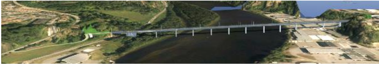
Figur 2-8 Dobbeltsporet krysser Lågen, Stålakekkorridoren. Sett fra sør, retning Larvik mot venstre.
