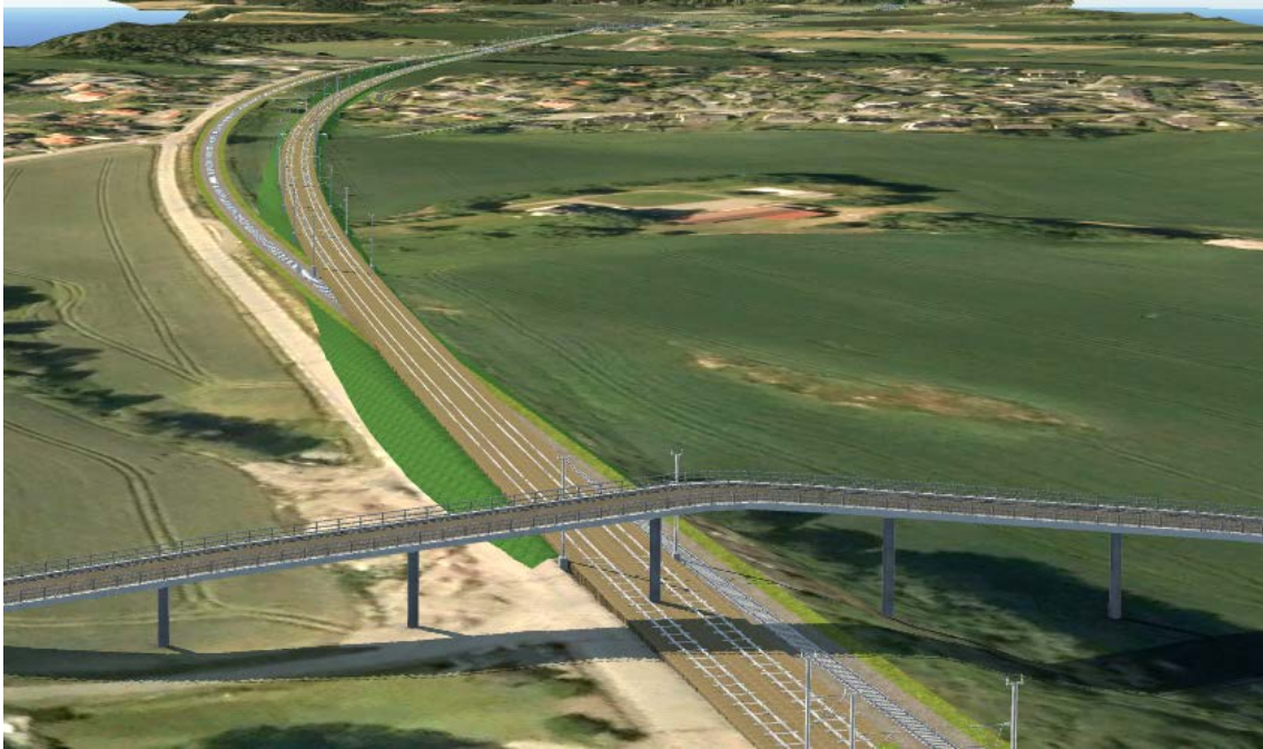
Figur 6-3: Nytt spor ved Virik skjer som en utvidelse og forskyvning av jernbanen mot vest. En ny overgangsbru etableres der småhusbebyggelsen langs Skiringssalveien grenser mot jordbrukslandskapet. Fra prosjektets arbeidsmodell sett i retning Larvik.
