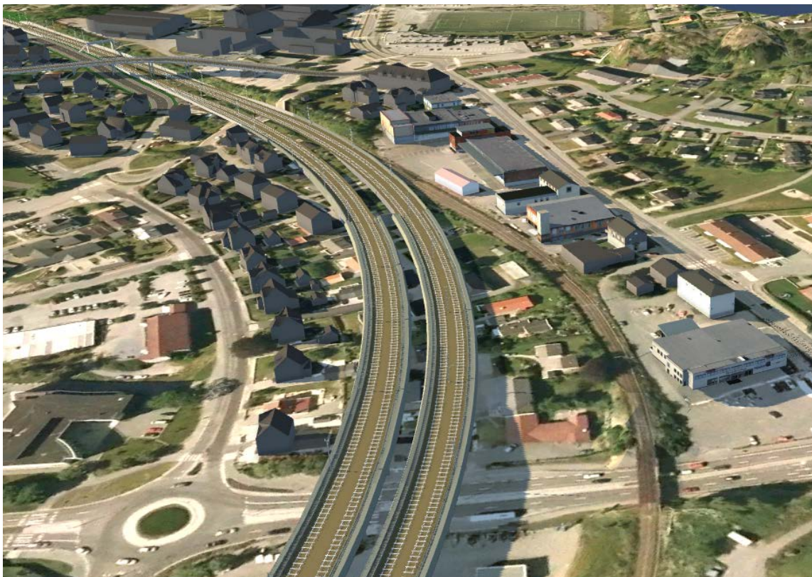
Figur 5-49 Betydelige deler av bebyggelsen mellom Sandefjordsveien og Bugårdsbakken må rives ved sporutvidelse og traséomlegging. Ny vegkryssing over sporene ved Leikvollgata vil videre kreve rivning av hus i denne gaten og ut mot Skiringssalveien. Vegomleggingen vil bli bearbeidet i senere planfaser. Fra prosjektets arbeidsmodell sett i retning Larvik.
