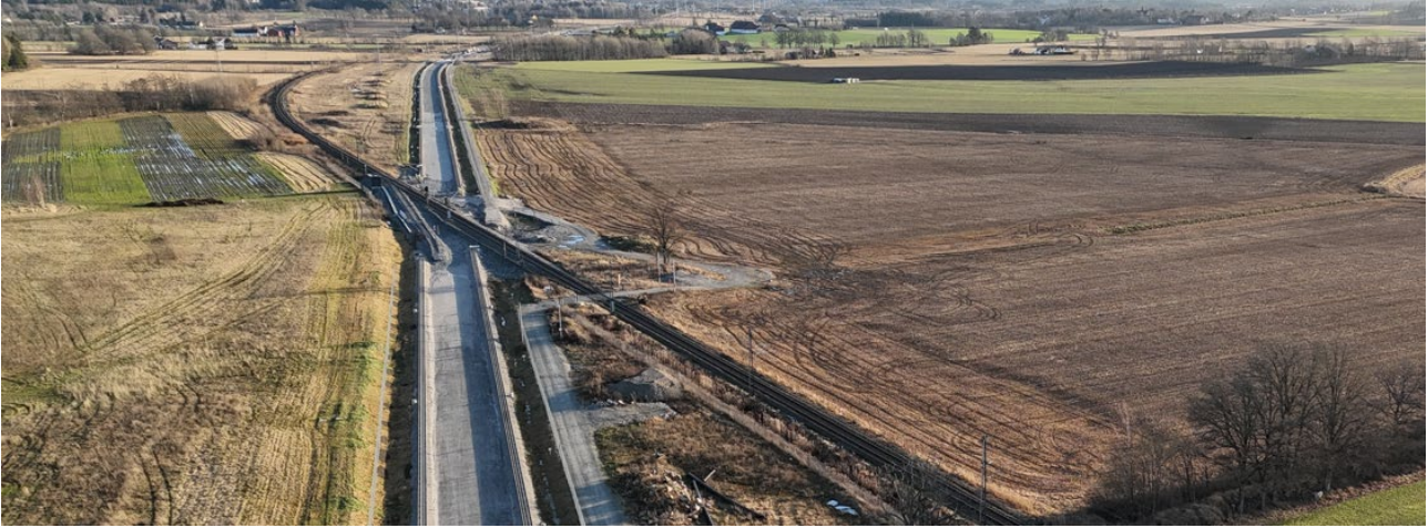
Figur 6. Underbygning for nytt dobbeltspor Dilling-Såstad. Foto: Bane NOR 2024.
