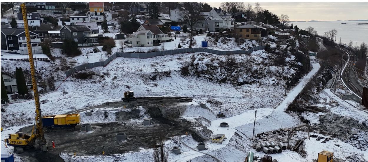
Figur 22. Ved Kleberget har vi montert støydempende matter på fast anleggsgjerde. Foto: Bane NOR.
