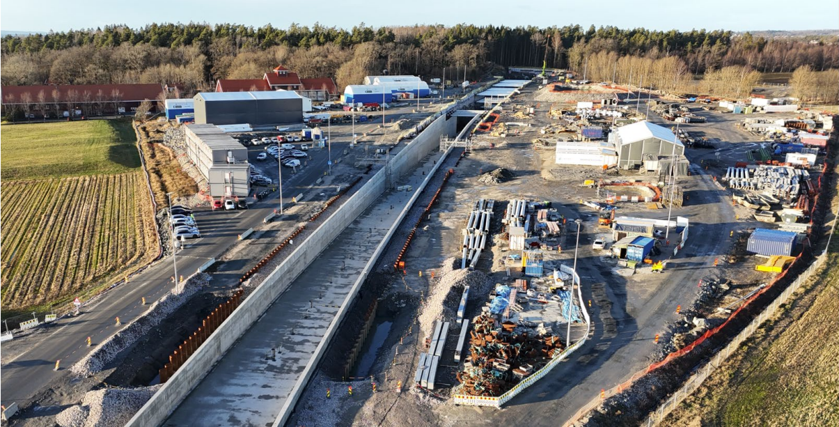
Figur 4. Kulvert Carlberg og riggområdet. Foto: Bane NOR 2024.
