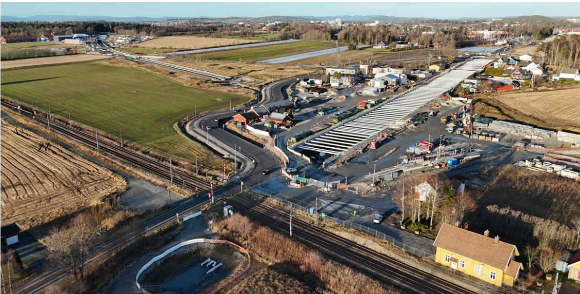
Figur 5. Veikulvert Larkollveien ved Dilling. Foto: Bane NOR 2024.
