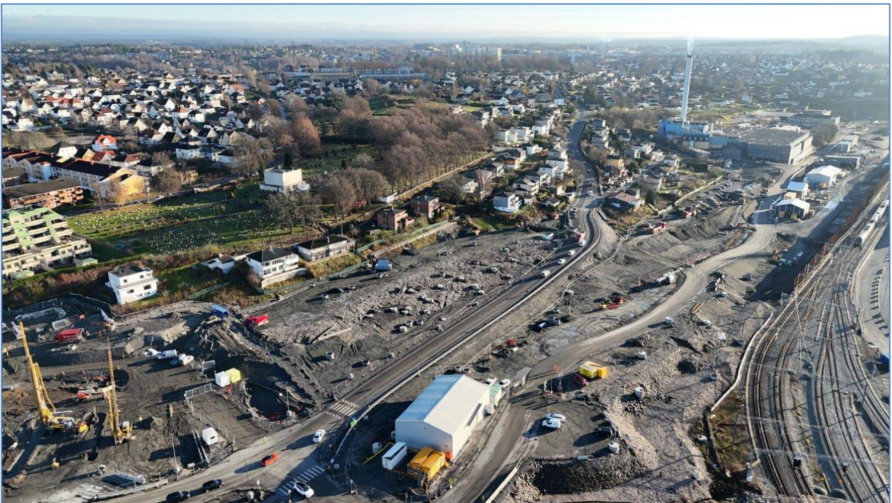
Figur 1. Stasjonsområdet i Moss sentrum, november 2024. Bane NOR har to vannrenseanlegg på området. De er synlig som to store, hvite telt. Foto: Bane NOR.
