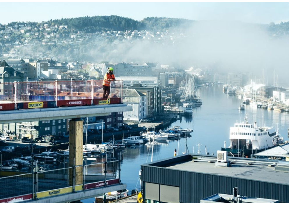
Hyggelig utsikt fra næringslokalene over terminalbygget som går opp til syvende etasje. De nye boligene vil ligge videre langs kanalen mot politihuset.
